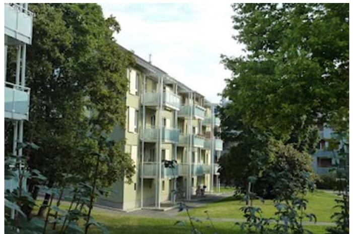
Bild 2: Die Wärmedämmung aus Neopor lieferte den größten Beitrag zur Heizenergieeinsparung bei der Modernisierung des Brunckviertels.
