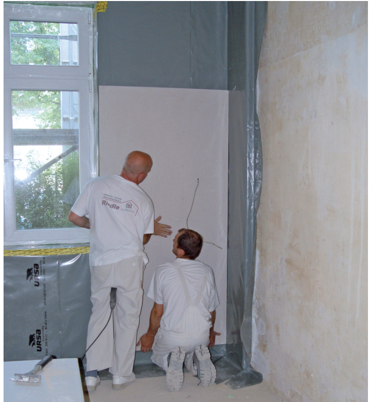
8 Montage einer zweiten Gipskartonplatte als Untergrund für Anstrich, Tapeten oder Fliesen.
