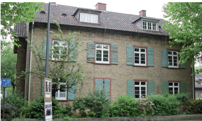
9 Gebäude mit erhaltenswerter Klinkerfassade: Das »Meisterhaus«, Sodastraße 40 in Ludwigshafen, Baujahr 1892.
