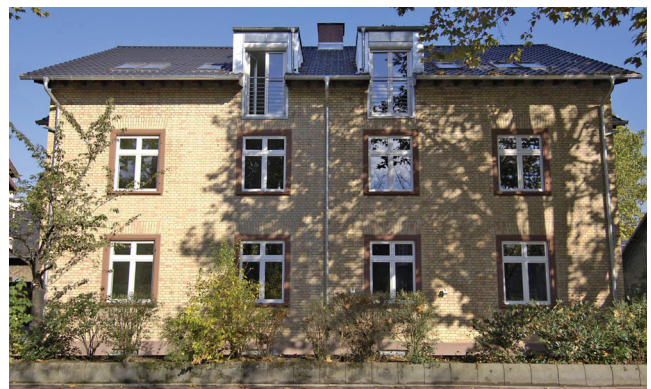
10 Sodastraße 40 nach der energetischen und architektonischen Modernisierung. Fotos/Grafiken: BASF
